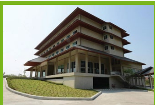
อาคารศูนย์การเรียนรู้กสิกรไทย จังหวัดฉะเชิงเทรา เป็นอาคารเขียว ที่ผ่านการรับรองตามมาตรฐานสากลระดับโลก ภายใต้ระบบ LEED
